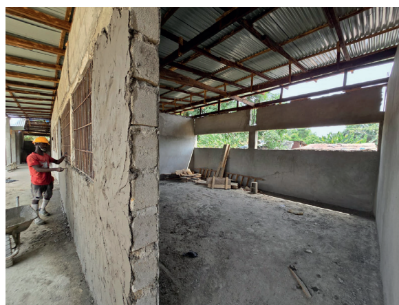
Die Bauarbeiten an der Hephz Foundation School sind im vollen Gange
